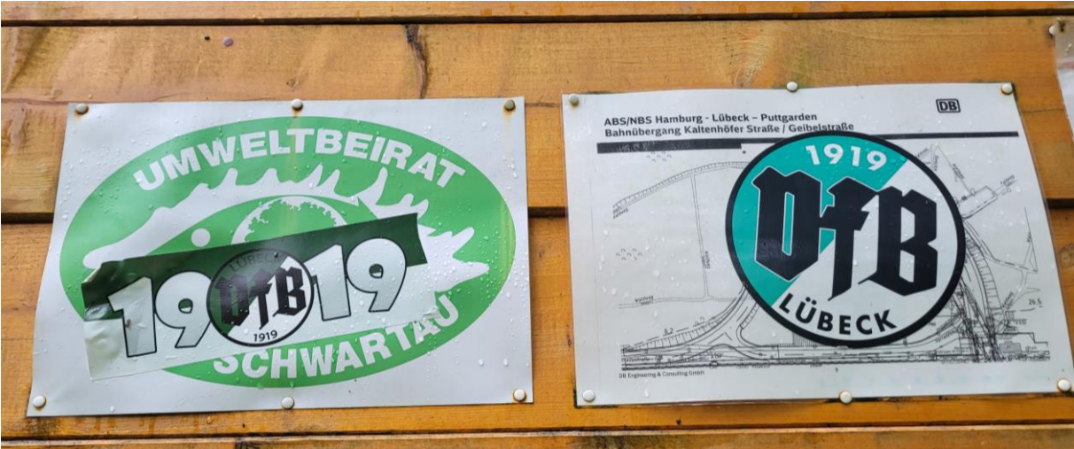
Anhang: Foto vom Vandalismus an der Modelllärmschutzwand
